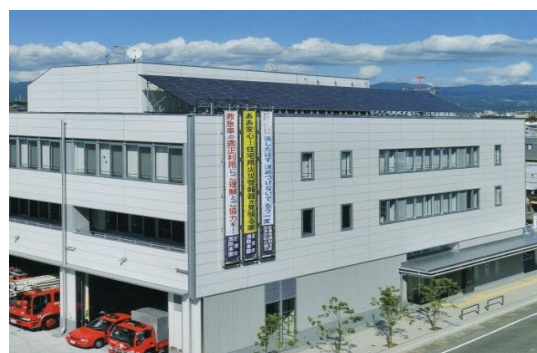
太陽光発電設備
